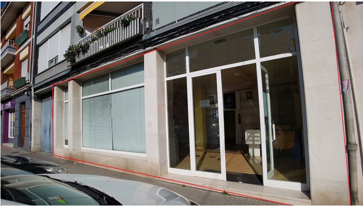
FACHADA DEL LOCAL
